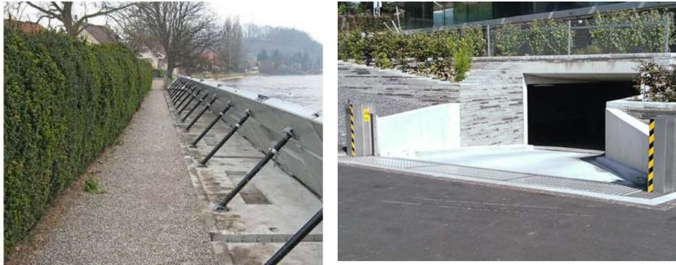
Abbildung 23: Klappschotts (Aeschlimann AG, JOMOS AG )
