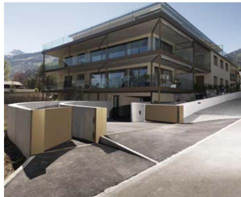
Abbildung 22: Dambalken und Fluttore (Aeschlimann AG, [schutz-vor-naturgefahren.ch](http://schutz-vor-naturgefahren.ch))
