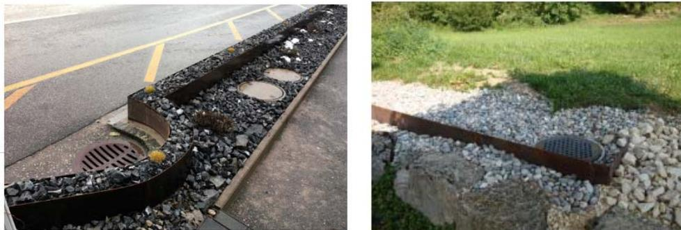
Abbildung 26: Schutzdämme mit Retention (schutz-vor-naturgefahren.ch)
