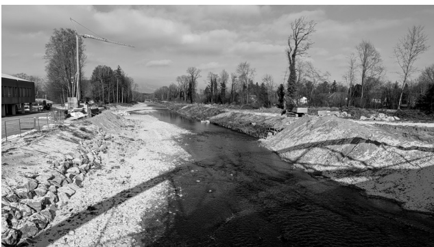
Bätterkinden-Brücke, Sicht in Richtung Baustelle.
