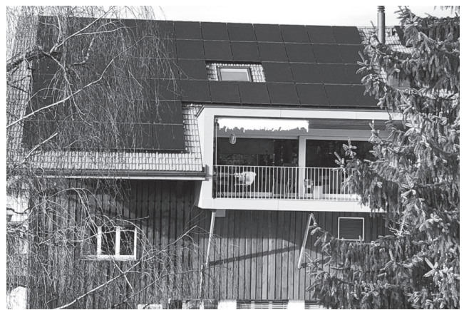
Im Jahr 2019 installierte Photovoltaikanlage auf dem Dach der ehemaligen «Krone».
