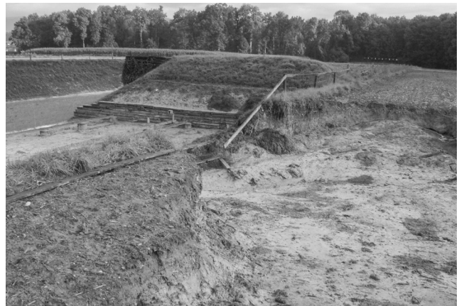
Scheibenstand der Schiessanlagen nach dem Hochwasser 2005.
