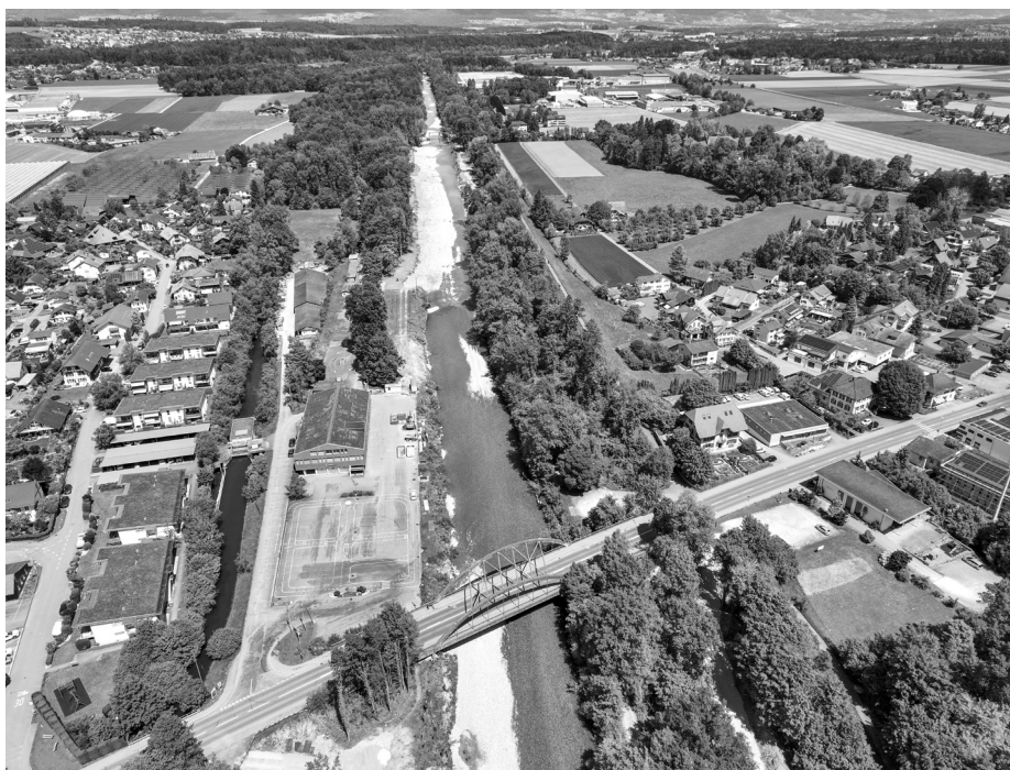
Bereits fertiggestellte Aufweitung der Sohle zwischen Emmenbrücke und Landshutwehr Seite Bätterkinden unterhalb Saal Anlage Bätterkinden.
