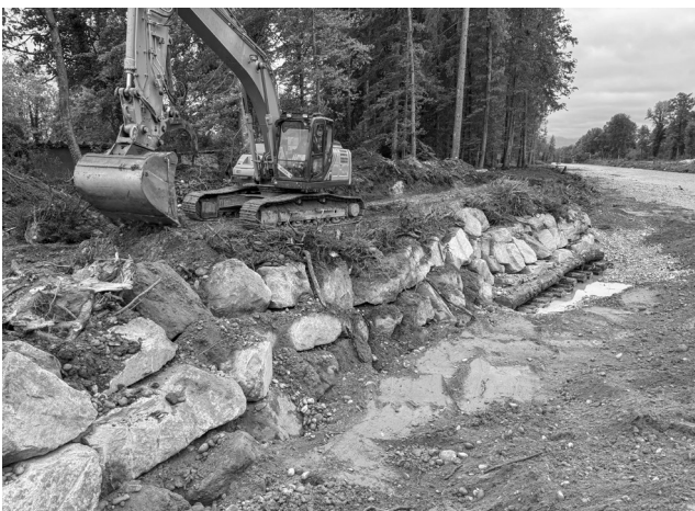
Abbruch bestehende Uferverbauung.
