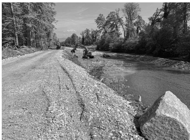
Arbeiten an und in der Emme.
