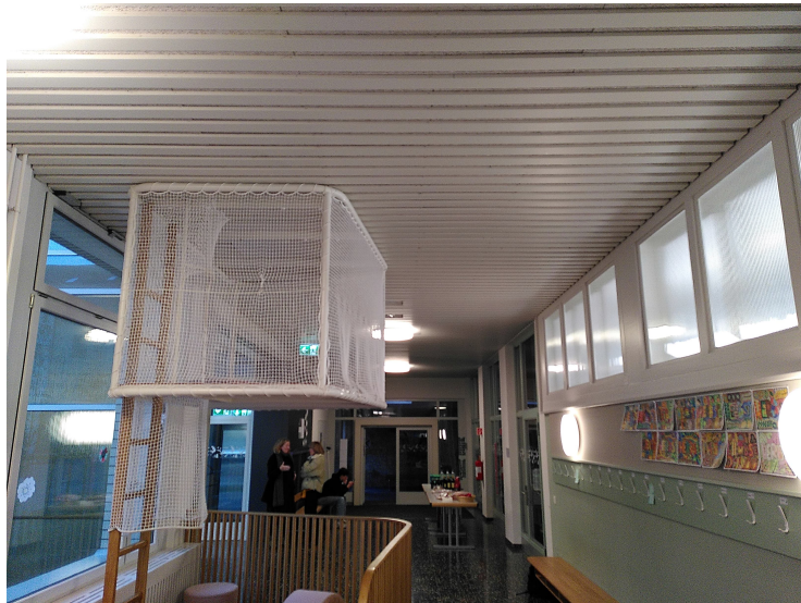
Beispiel Schulhaus Erlen, Glarus Deckenabsorber und Wandabsorber
