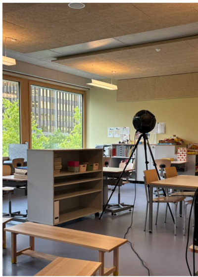
Beispiel Schulhaus Thurgauerstrasse Zürich Deckenabsorber und Wandabsorber
