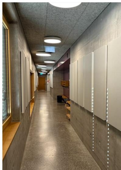
Beispiel Kinderbetreuungshaus Herrliberg Deckenabsorber und Wandabsorber
