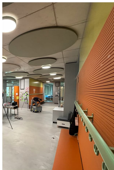
Beispiel Schulhaus Thurgauerstrasse Zürich Deckenabsorber und Wandabsorber
